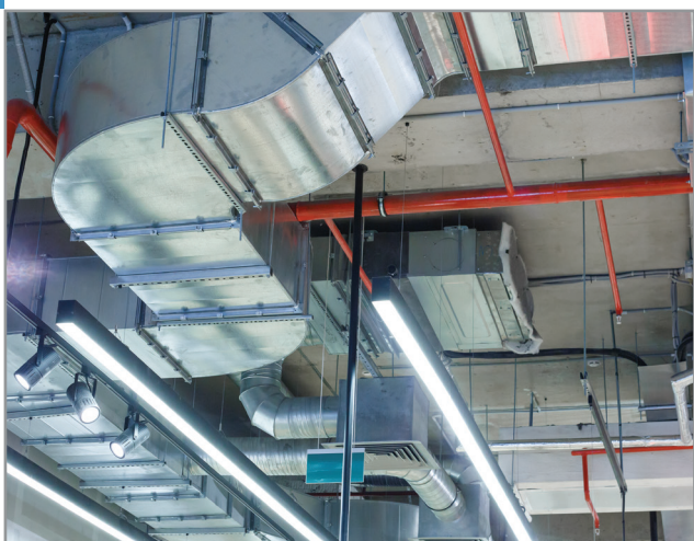
THI CÔNG ĐIỆN, ĐIỀU HÒA ỐNG GIÓ
