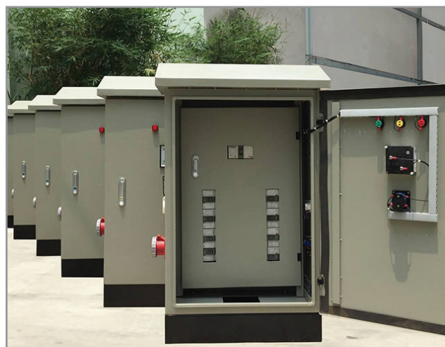
KINH DOANH SẢN PHẨM ĐIỀU HÒA ỐNG GIÓ, TỦ ĐIỆN, BẢO ÔN, ỐNG GIÓ MỀM
